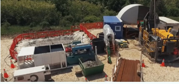
Sondaj çalışmaları için havuz sistemi ve çevre güvenliğinin alınması. The provision of a pool system and environmental safety for drilling operations
