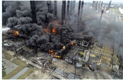
Teksas'ın Port Neches kentindeki kimya tesisinde 2019'da bir aydan fazla süren yangın Fire at a chemical plant in Port Neches, Texas, that lasted for more than a month in 2019
